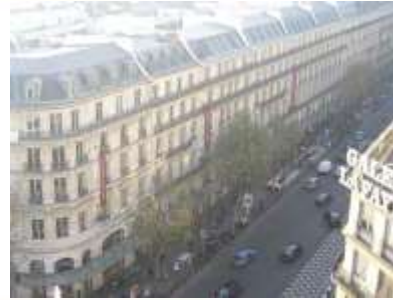
la façade Haussmannienne
